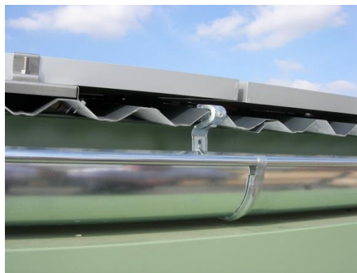
Pose sur imposée dit « intégration simplifiée »
