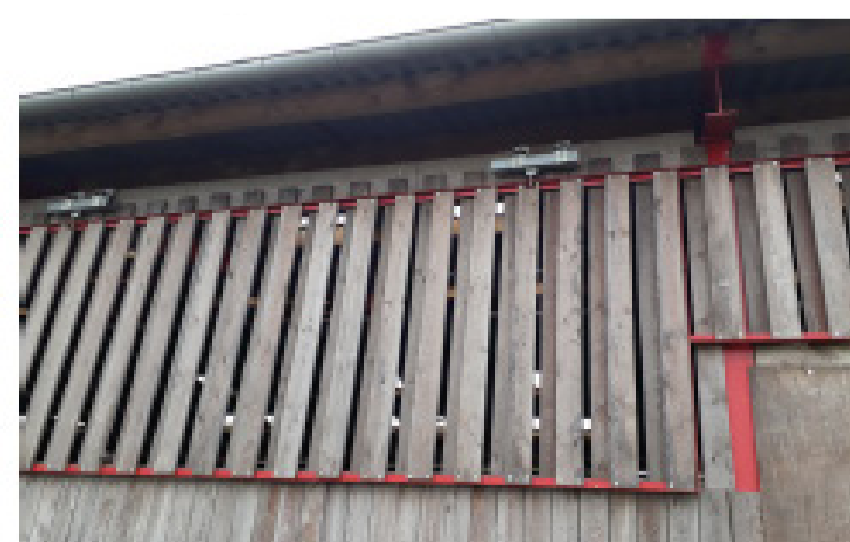
Aménagement d'un bardage ajouré coulissant (IDELE)
