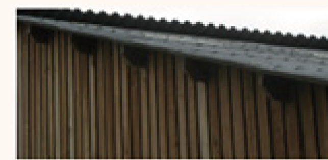
Faitière décalée Croisement des tôles au faitage. Non conseillé car peu d'efficacité avec risques de retombées d'air froid.
