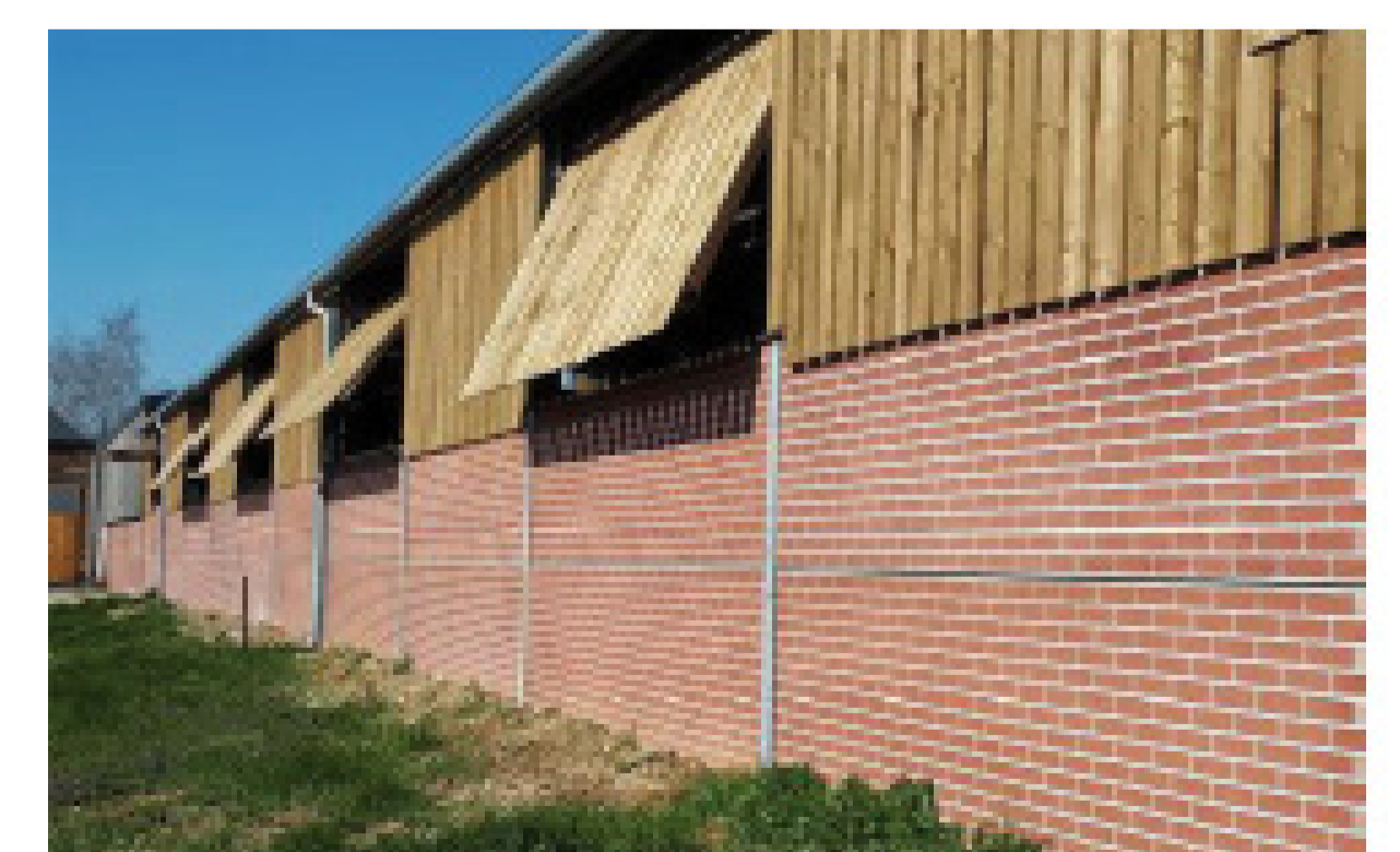
Aménagement d'un volet articulé (CA de l'Aisne)
