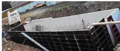
Cuve maçonnée enterrée
